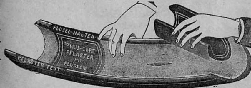
Reparaturpflaster zur Innenreparatur des Mantels. Der äußere Riß wird sodann mit Zement Nr. 26/29 verschmiert oder mit Reparaturband Nr. 26/20-22 verdeckt.
